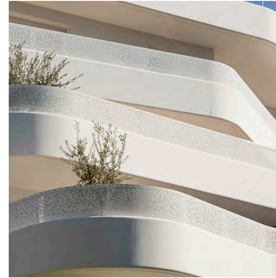
CONCRETE SLAB EDGE
